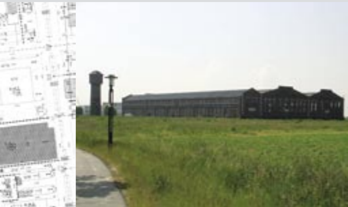
Blick auf die Halle 4 vom Eingang des Gewerbeparks
