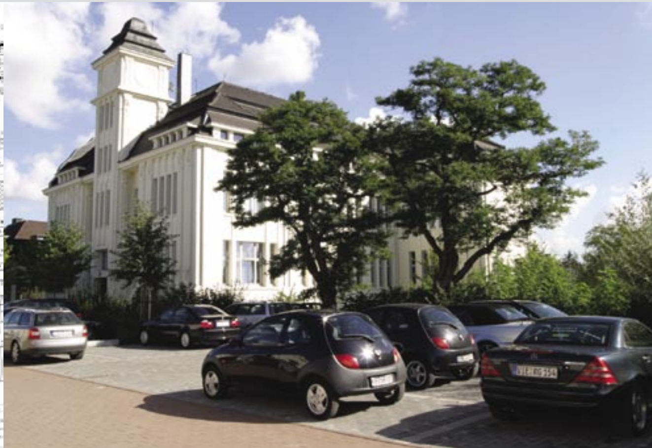
Das restaurierte Verwaltungsgebäude
